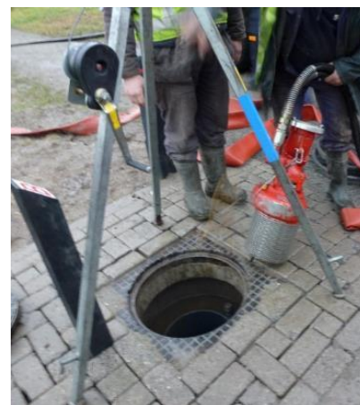
Figuur B1.4. Een open brandput die zo is uitgevoerd dat er door de brandweer van bovenaf een zuigslang of dompelpomp kan worden ingehangen. Linksboven: werktekening. Rechtsboven: werktekening, detail bronkop. Linksonder en rechtsonder: voorbeelden van een gerealiseerde put.
